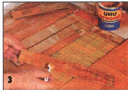
3 Обильно промазывают свежим контактным клеем высушенные и очищенные от старого клея паркетные дощечки, а также основание пола.
