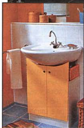
Экран в виде шкафчика с подогнанными к контурам умывальника самодельными дверками.
