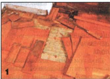
1 Снимают, сушат и чистят отслоившиеся дощечки паркета. Заделывают трещины в основании монтажной пеной. Срезают выступающую затвердевшую монтажную пену.
