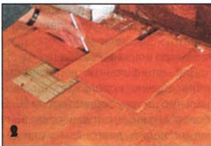
2 Проверяют исправность основания пола или иной опорной конструкции. При необходимости его ремонтируют.
