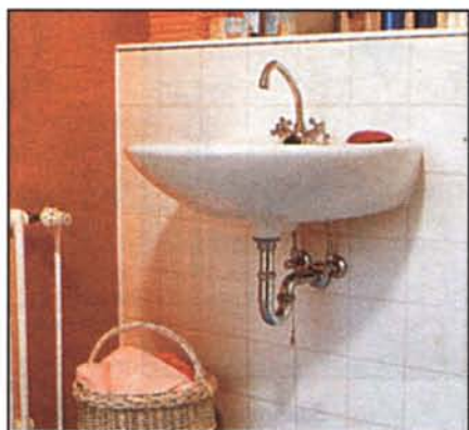
Так или примерно так выглядит умывальник с открытыми трубами, вентилями и сифоном.
