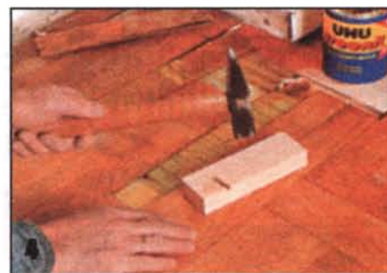
4 Выдержав контактный клей определённое время, указанное в инструкции на упаковке, укладывают дощечки на прежнее место, подгоняя их молотком через вспомогательный брусок.
